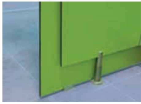
Detalle inferior puerta corredera.
