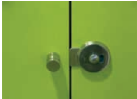
Detalle pomo y condena de puerta con visor libre/ocupado.
