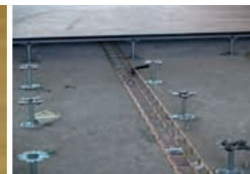
Montaje de estructura suelo técnico (pedestales).
