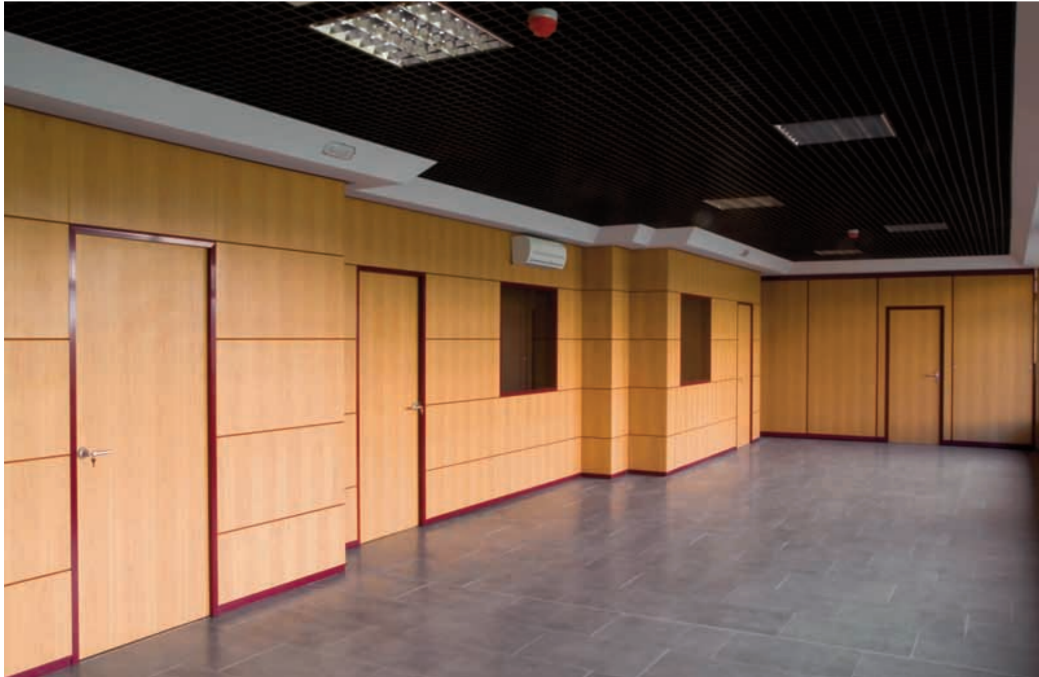
Interior mampara a franjas: perfilería y lana de roca aislante.
