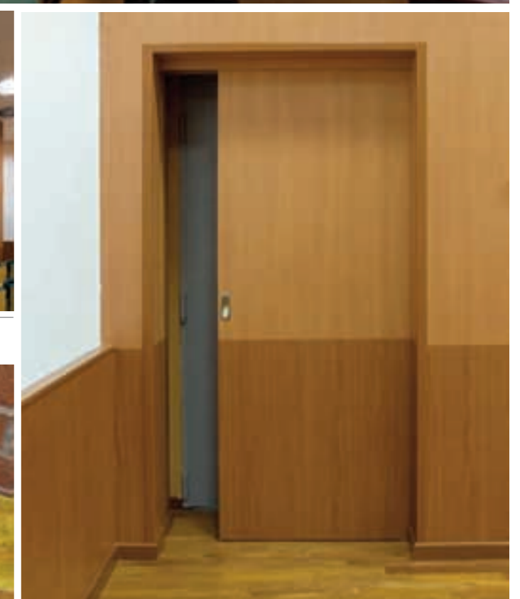
Puerta corredera a tabique con idéntico acabado al forrado de pared.
