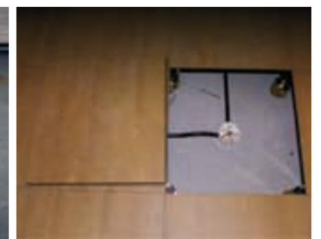
Instalación bajo placa del suelo técnico.
