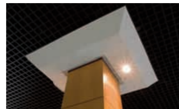
Forrado de pilares. Detalle encuentro a techo.
