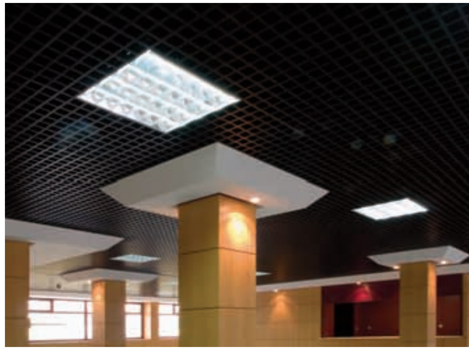
Falso techo reticular de 75x75x15 mm. en color negro (Cellio) con panel aislante y velo negro.
