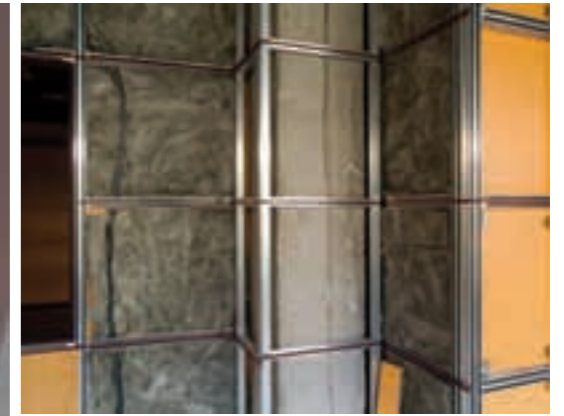
Interior mampara a franjas: perfilería y lana de roca aislante.
