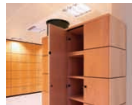
Tabique armario independiente siguiendo línea de diseño.
