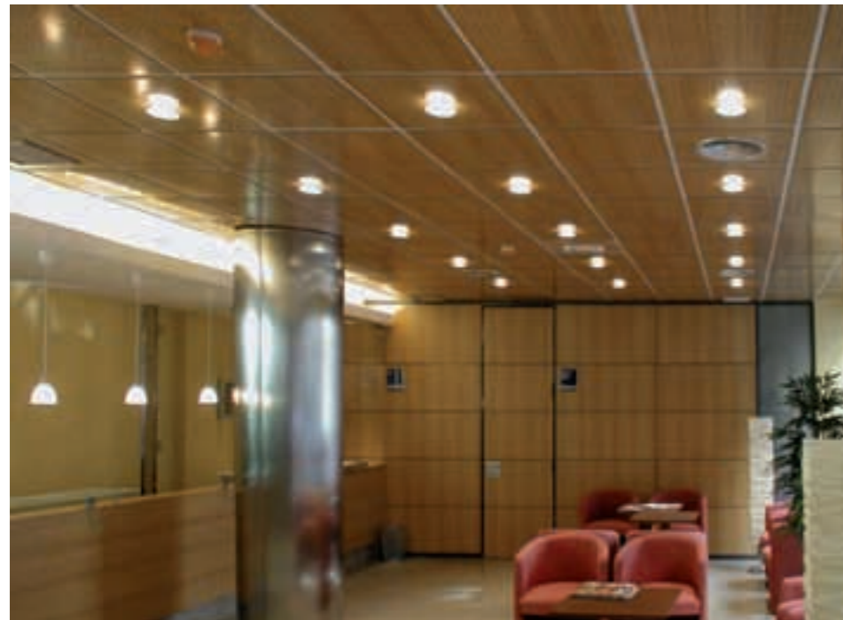
Falso techo de madera barnizada y perforada sobre perfil.
