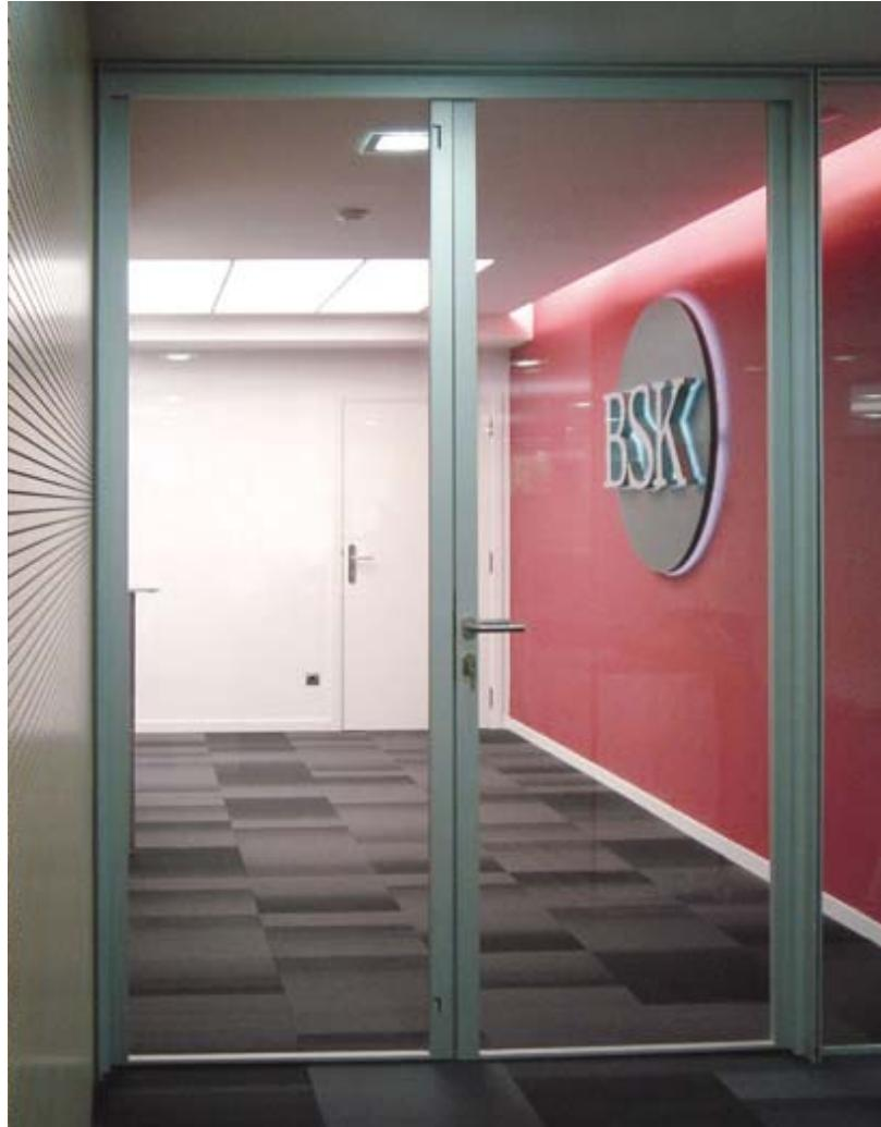
Puerta doble de cristal enmarcada de 30 mm con cristal laminar 3+3. 30 mm double door with framed 3+3 laminate glass. Porte double en verre à encadrement de 30 mm avec verre laminé 3+3. Umrahmte, 30 mm starke zweiflügelige Glastür mit 3+3-Verbundglas.
